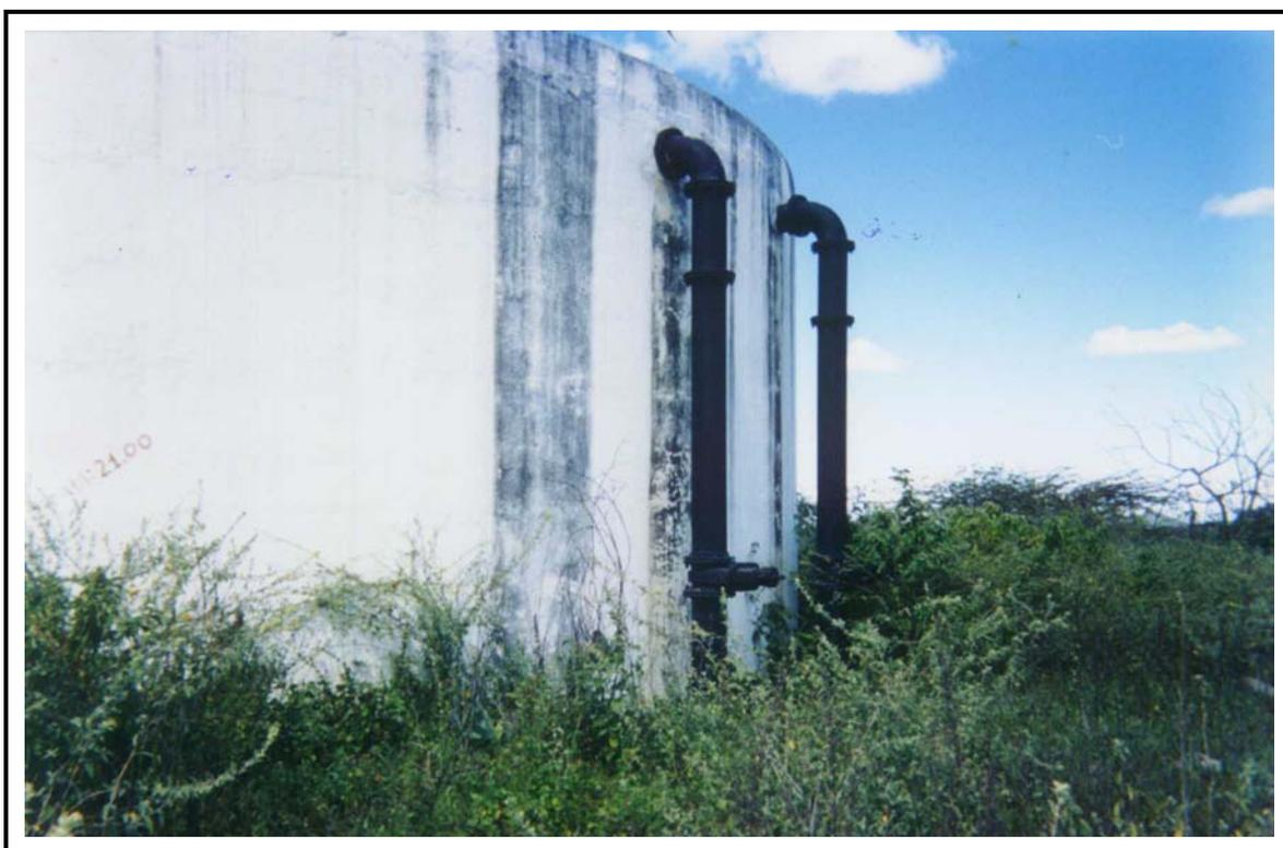
**Foto 08** - Reservatório apoiado construído em 02 células - Entrada d'água bruta.
