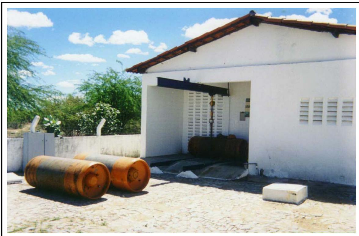
**Foto 20** - ETA-Tauá - Pré-cloração na entrada de água bruta, aplicada a montante da torre de nível. Pós-cloração na saída do reservatório apoiado de água filtrada (antes da sucção das bombas).
