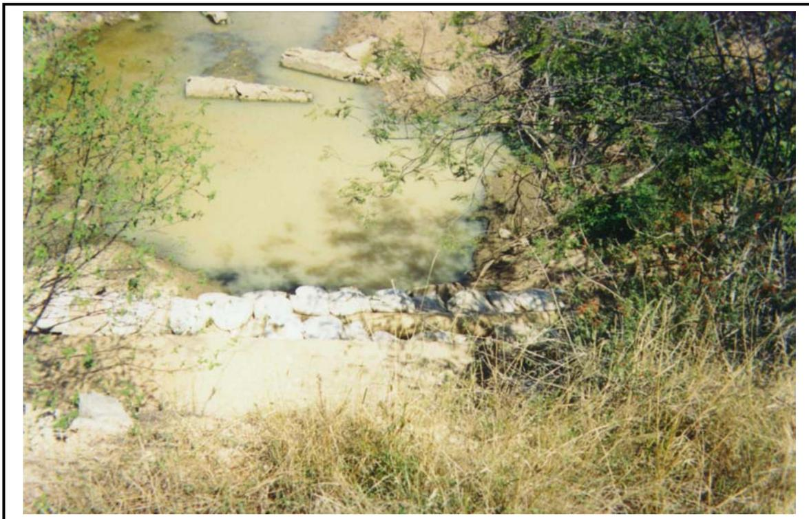
**Foto 11** - Adutora de água bruta - Trecho rompido (danificado) em decorrência da barragem rompida. Trecho da adutora de água, instalado a jusante do bueiro da estrada, totalmente envelopado em concreto e rompido em decorrência da ruptura da barragem a montante. Trecho recuperado provisoriamente com sacos de areia.
