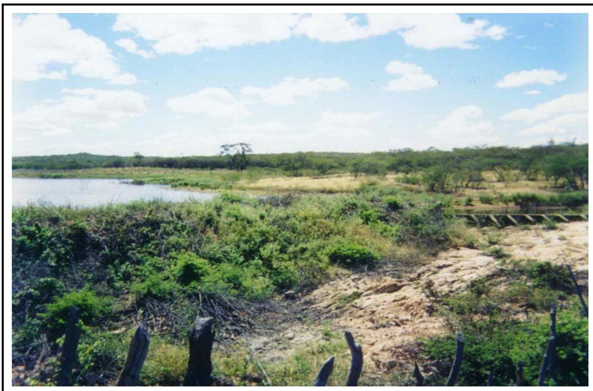
**Foto 14** - Adutora de água bruta - Barragem e vertedouro de açude a montante do caminhamento da adutora. Não existe manutenção e o trecho da barragem adjacente à estrada tem bastante formigueiros que devem ser eliminados para prevenir acidentes.
