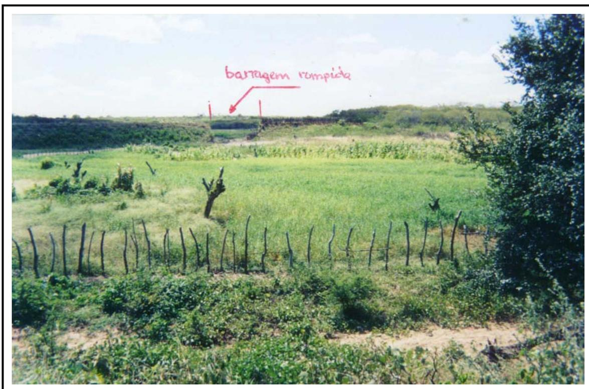
**Foto 10** - Adutora de água bruta - Barragem rompeu a montante e provocou ruptura da adutora de água bruta à jusante do bueiro da estrada.
