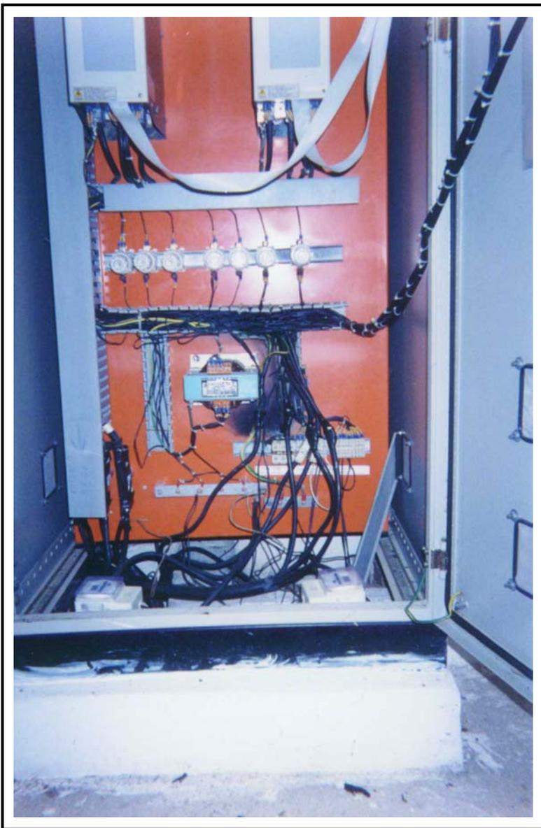
Foto 05 - Painel de comando das bombas da captação flutuante.
