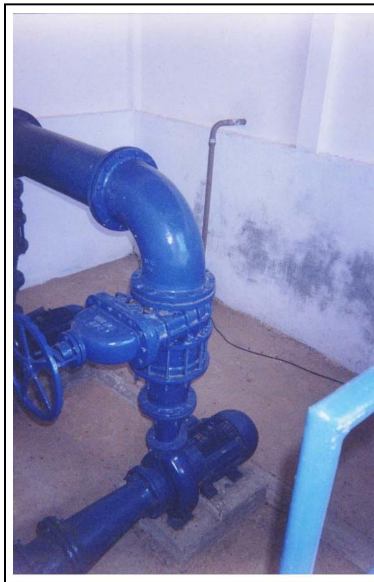
Foto 22 - ETA-Tauá - EB que recalca água tratada do reservatório apoiado para o reservatório elevado de distribuição.
