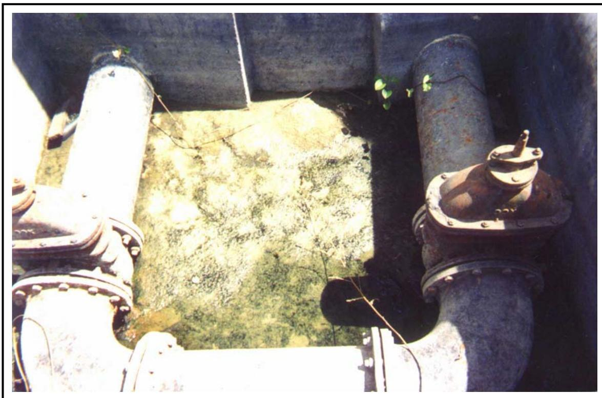
**Foto 09** - Reservatório apoiado - Saída d'água bruta. Sistema de interligação e manobra das duas células.
