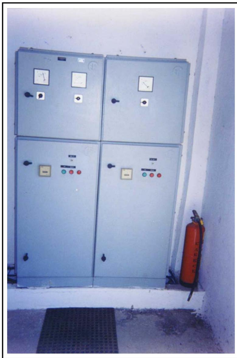
**Foto 23** - ETA-Tauá - EB - painel de comando das bombas.
